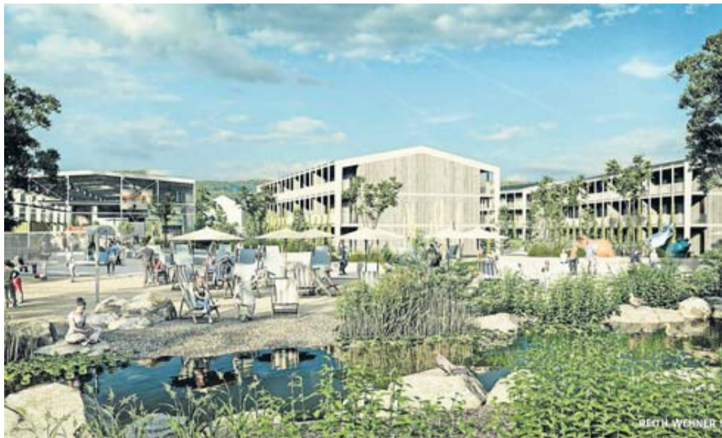
Nach den aktuellen Plänen sollen auf dem Vogt-Areal zahlreiche Wohnungen entstehen. Hier der Blick vom Kinzigstrand her. Foto: Stadt Schlüchtern
