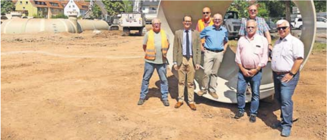
Ortstermin an der Großbaustelle.
