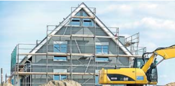
Auf den Baustellen in Deutschland sind in letzter Zeit die Rohstoff-Preise nahezu explodiert. Die Firmen müssen diese an künftige Bauherren weitergeben. Foto: Hauke-Christian Dittrich/dpa/dpa-mag
