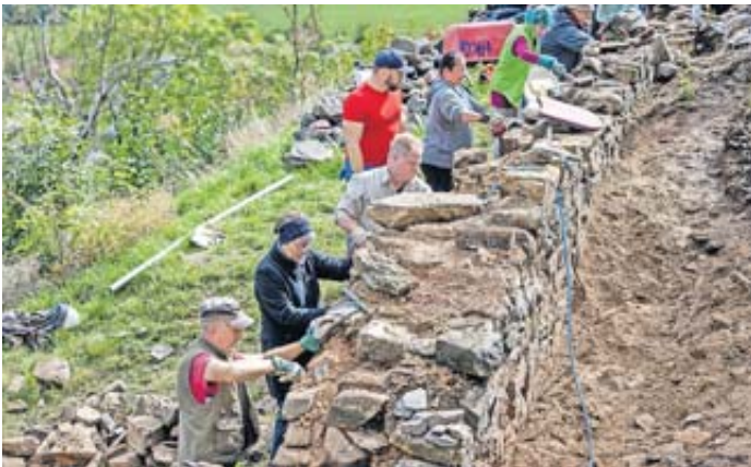
Zahlreiche Ehrenamtliche haben eine Woche lang bei der Sanierung der Burgruine unterstützt. Foto: Sebastian Mannert
