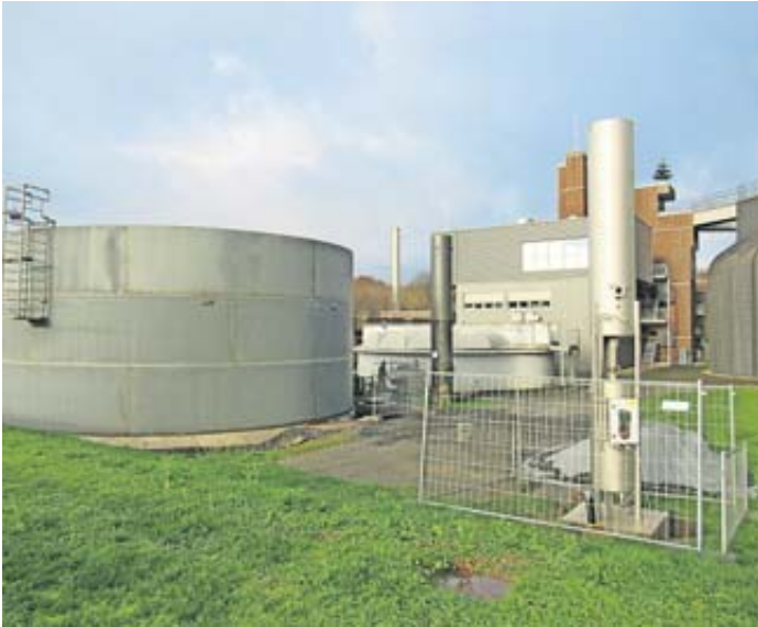
Durch die Errichtung eines zweiten Gasspeichers am Klärwerk Gläserzell erhöht sich die Speicherkapazität von 1.000 auf 1.800 Kubikmeter.
