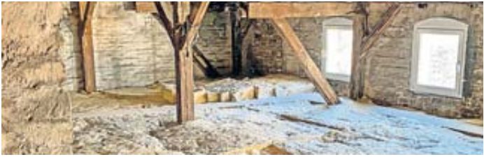
Wer ein Haus kauft, muss die oberste Decke über beheizten Räumen oder das Dach dämmen. Das kann man - handwerkliches Geschick vorausgesetzt - auch selbst tun.
