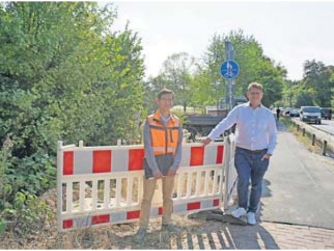
Christian Kischka vom Fachdienst Infrastruktur, Kanal und Straße und Bürgermeister Sebastian Wysocki schauen sich auf der Baustelle um.
