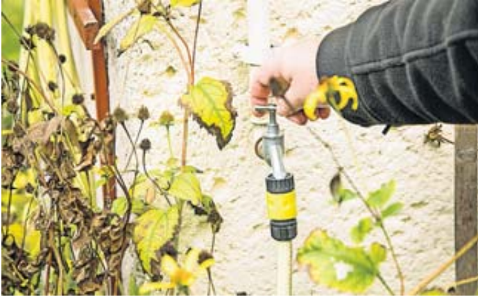
Um Rohrbrüchen vorzubeugen, müssen zum Ende des Herbstes alle Wasserleitungen im Außenbereich abgestellt und entleert werden.
