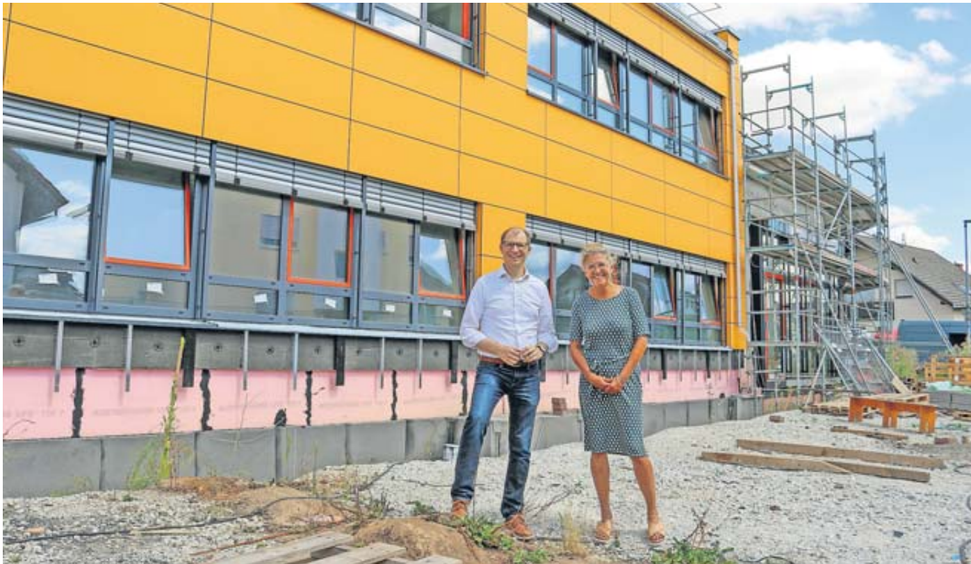
Besichtigen gemeinsam die Baustelle: Landrat Jan Weckler und Schulleiterin Sabine Zecha.
