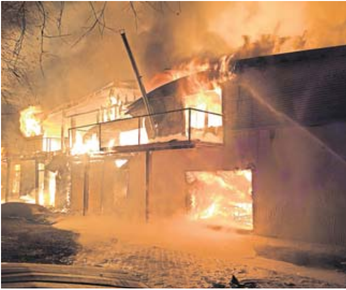
Ein Fall für die Freiwillige Feuerwehr: Brennende Lagerhalle in Büdingen (Archivbild).
