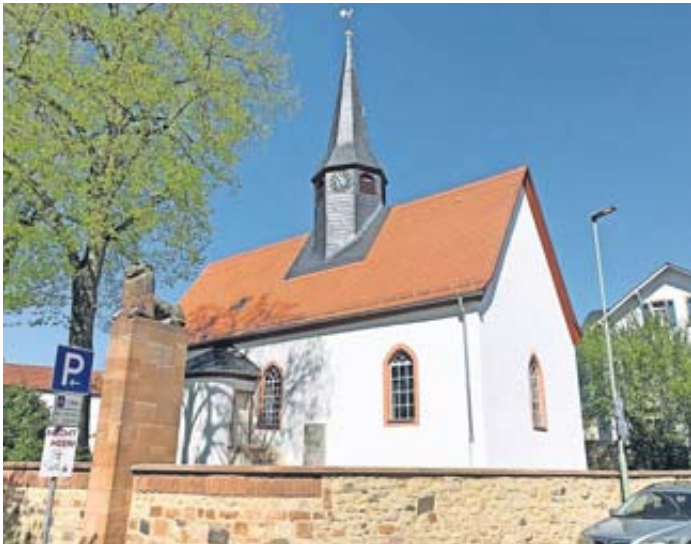
Fürs Auge nicht sichtbar sind die wichtigen Arbeiten im Dachgebälk.
