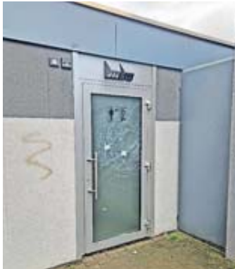
An der Tür zur Herrentoilette am Marktpavillon sind die Schäden offensichtlich.
