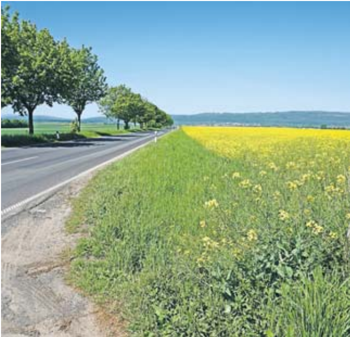
Entlang der Kreisstraße 11 zwischen Nieder-Rosbach und Ober-Wöllstadt wird ein neuer Geh- und Radweg gebaut.
