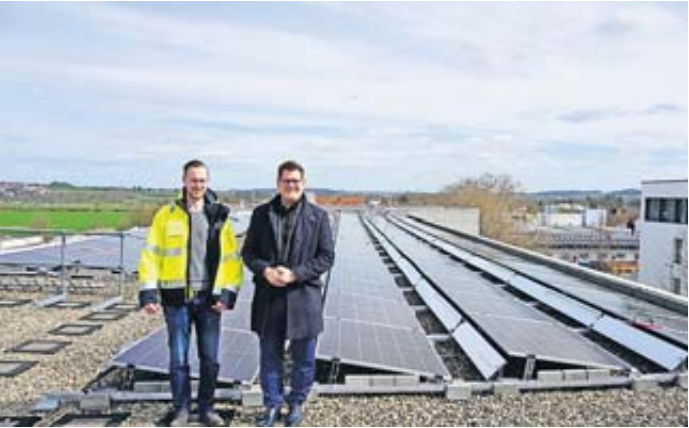
Daniel Schröder von den Stadtwerken erklärt Bürgermeister Sebastian Wysocki die Leistungsfähigkeit der installierten Photovoltaikanlagen.
