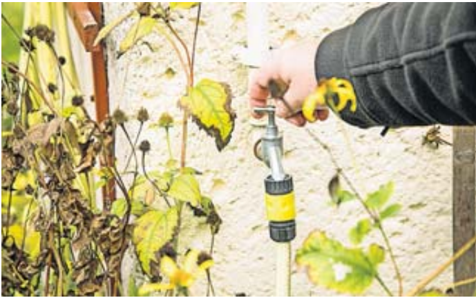
Um Rohrbrüchen vorzubeugen, müssen zum Ende des Herbstes alle Wasserleitungen im Außenbereich abgestellt und entleert werden. Foto: Christin Klose/dpa-mag
