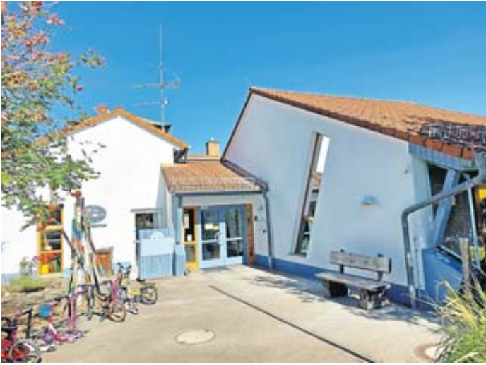
Rund um den Eingangsbereich wurde die Fassade neu angelegt, Fenster und Türen in diesem Bereich erhielten ebenso einen neuen Anstrich.
