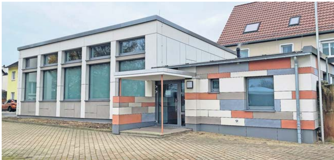
Seit einiger Zeit können die Vereine die umgebaute Halle wieder nutzen.
