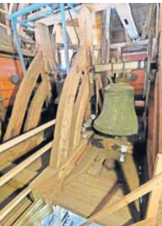
Bauarbeiten am Glockenturm in Rodheim.
