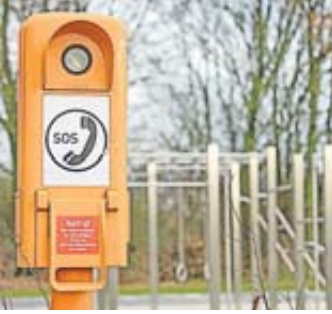
Notrufsäulen entlang der Autobahnen können im Not- oder Pannenfalle Hilfe vermitteln.
