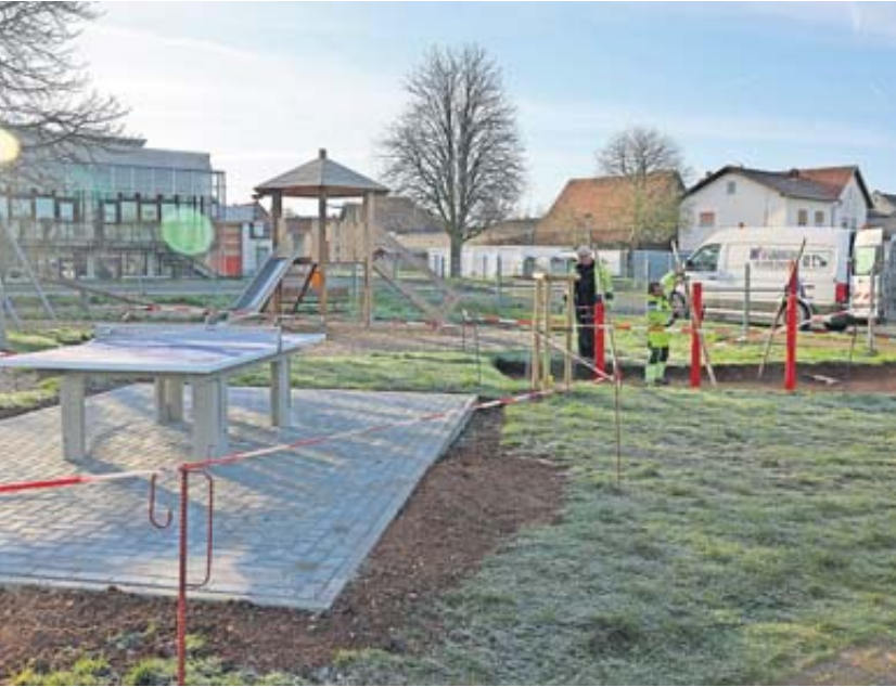
Auf dem Spielplatz an der Mehrzweckhalle in Berstadt wurden eine neue Tischtennisplatte installiert.
