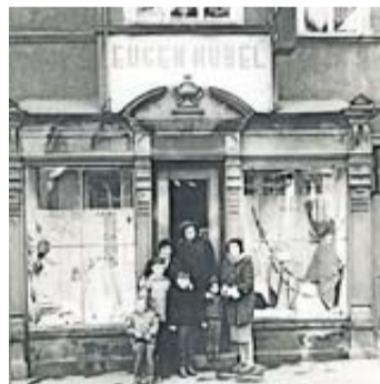
Griedeler Straße Nr. 11, ca. 1955.
