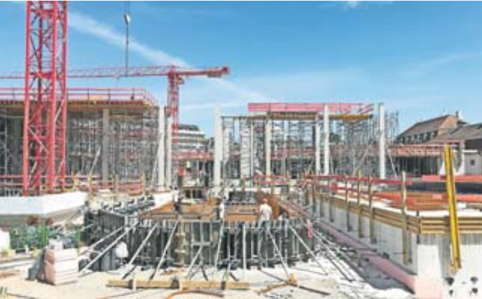
An zwei Terminen gibt es kostenlose Sonderführungen über die Baustelle der zukünftigen „Sprudelhof Therme“.
