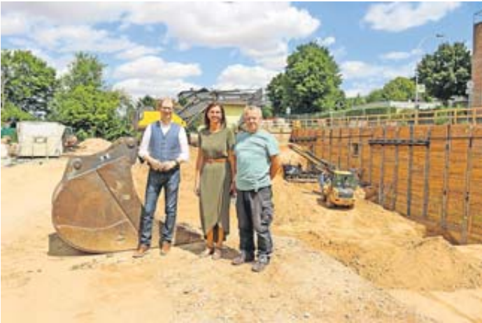
Landrat Jan Weckler, Konrektorin Susanne Wenisch und Hausmeister Michael Litzba besichtigen die Baustelle im Karbener Weg.
