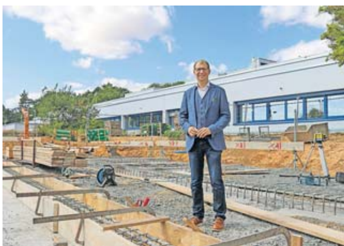
Landrat Jan Weckler besichtigt die Baustelle an der Butzbacher Weidigschule, auf der gerade das Fundament für die Containeranlage entsteht.
