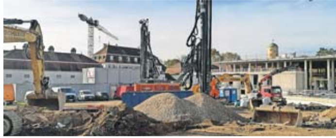
Hier entsteht die Tiefgarage für die Bad Nauheimer Sprudelhof Therme.
