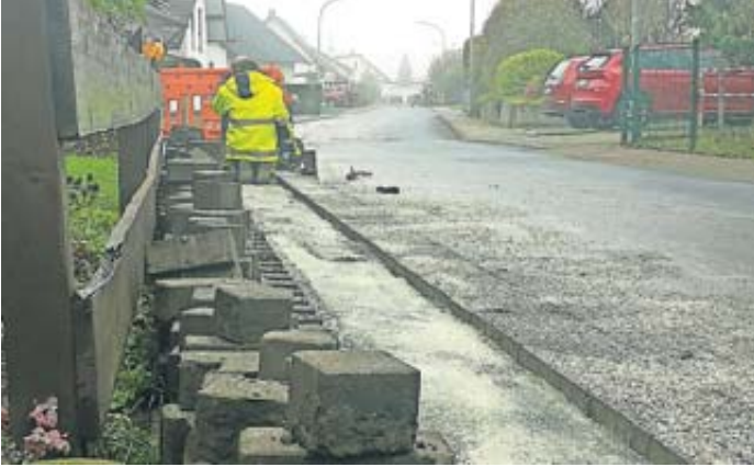
Gambach ist die erste Station bei den Tiefbauarbeiten für den Glasfaserausbau in Münzenberg.
