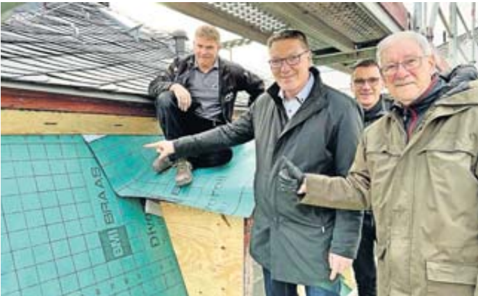
Bastian Meyendriesch, Geschäftsführer der Meyendriesch-Dach GmbH & Co. KG, Erster Stadtrat Peter Krank sowie Volker Buchholz, Fachdienstleiter der städtischen Immobilienverwaltung, und ehrenamtlicher Umweltschutzbeauftragter Rudi Nein sind mit der Nist-Lösung für die Mauersegler zufrieden. (von links)
