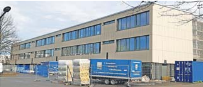
Den sanierte Westriegel.
