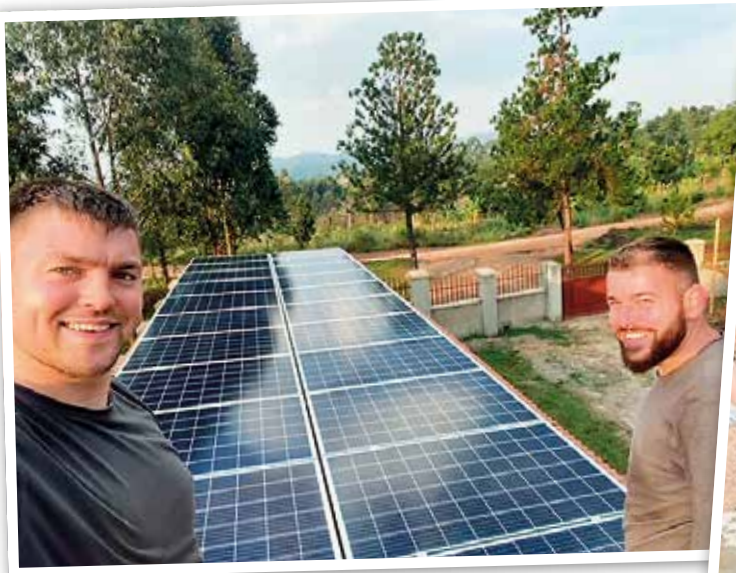
Montage der Solaranlage auf dem Container. Das erste Mal fließendes Wasser.
