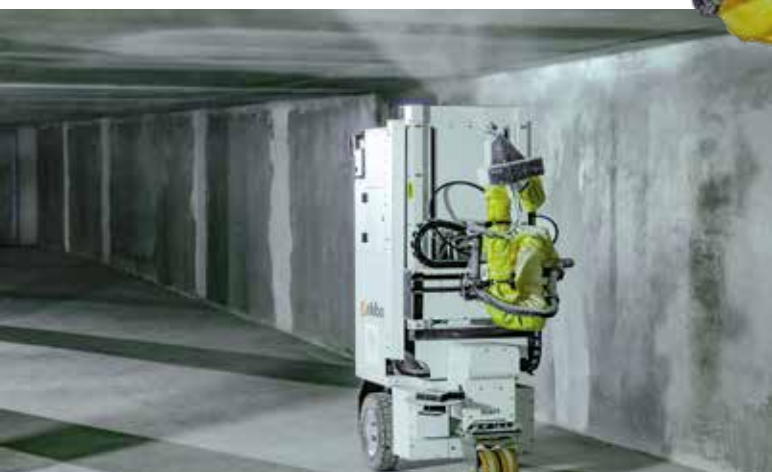
Teamwork im Test: Vorarbeiter Michael Seymour von der temps GmbH Malereibetriebe sammelt wichtige Praxiserfahrung mit dem Beschichtungsroboter.
