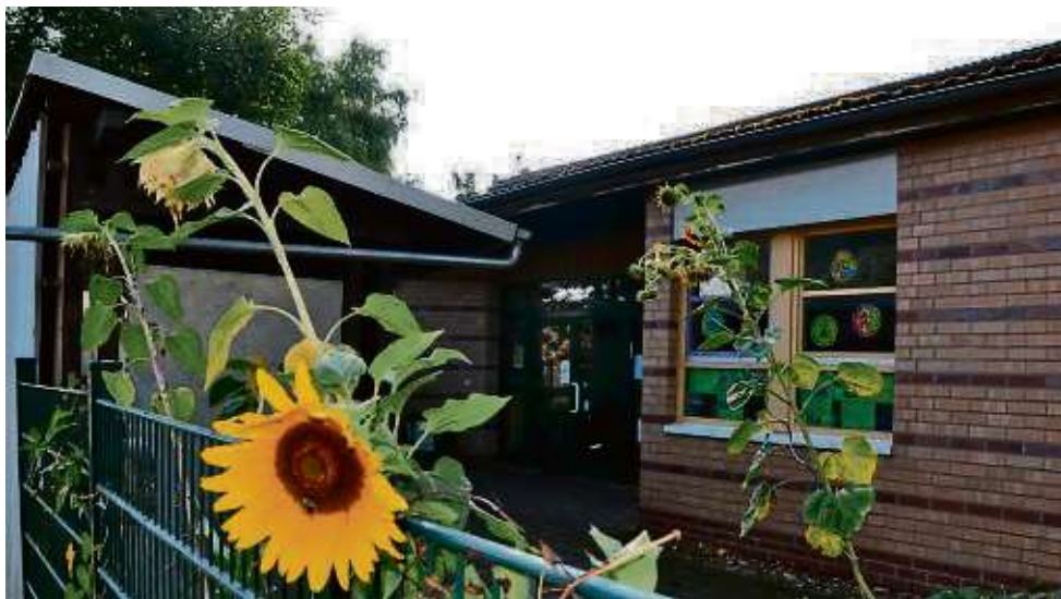
Die Kita An der Seife in Ostheim musste aufgrund eines Wasserschadens in eine Container-Anlage am Festplatz umziehen.
