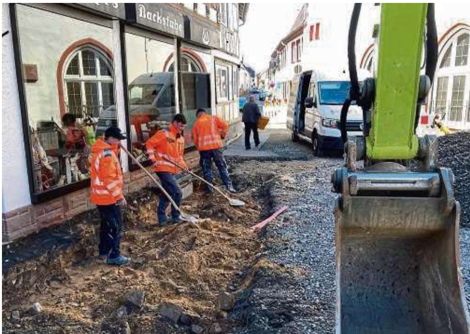
Vor der Filiale von Philippi's Backstube am Marktplatz in Windecken ist bereits zum dritten Mal der Boden aufgerissen.
