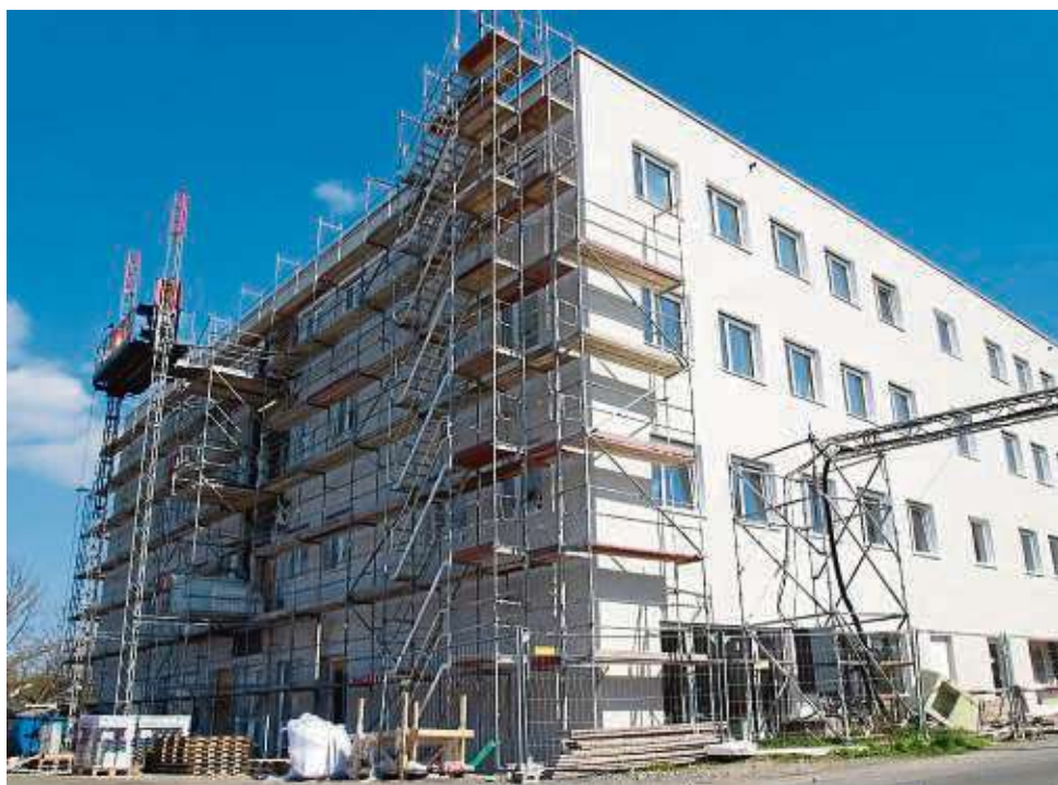
Noch gibt es viel zu tun auf der Baustelle des neuen Ärztehauses. In knapp drei Monaten soll die erste Praxis bezugsfertig sein.
