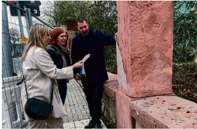
Begutachten das Bruchstück einer verunglückten vorherigen Sanierung der Sandsteinpfeiler am Park von Schloss Philippsruhe: Sibylle Jesgarz, Susanne Sittinger und Hanno Born (von links).
