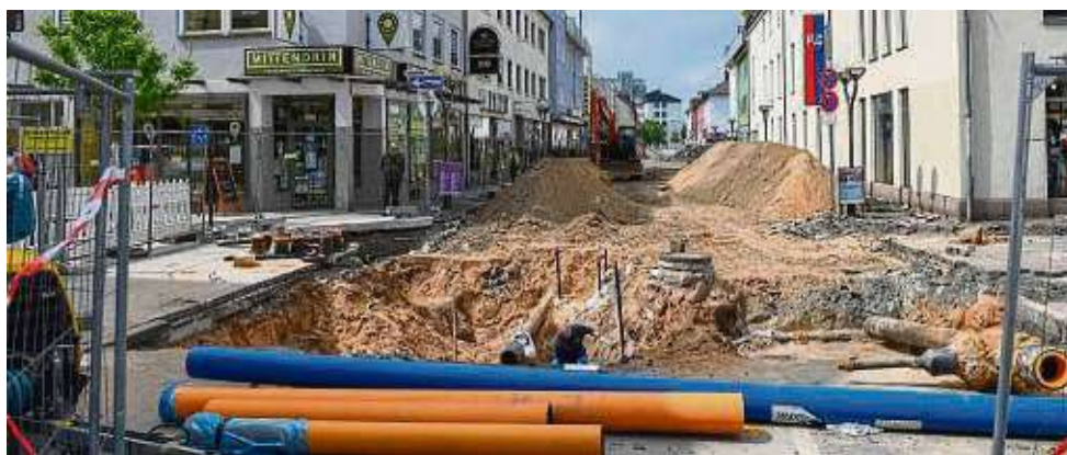
Trotz der Baustelle in der Römerstraße ist die Marktplatz-Tiefgarage weiterhin geöffnet und über Umleitungen zu erreichen, informiert die Stadt.
