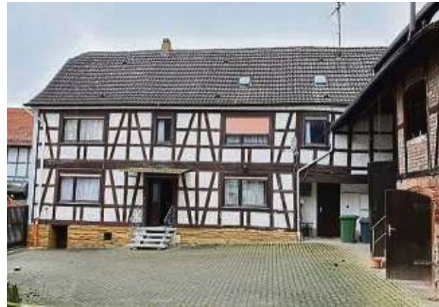
Die Außenansicht zeigt das Fachwerkhaus in der Ostheimer Schinnergasse noch vor Beginn der Sanierungsarbeiten.
