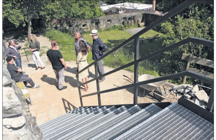
Der Aufgang zur Empore auf dem Mainzer Keller ist fast fertig. Künftig sind diese Plätze von einem Plateau im Ostzwinger aus zu erreichen. Während der Festspiele werden dort Stehtische aufgestellt. Fotos: bpa
