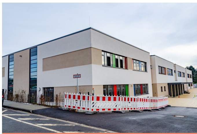
Erhebliche Baumängel an der neugebauten Wickerbach-Schule.
