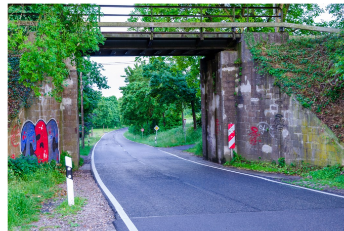
Bahnunterführung an der L3028
