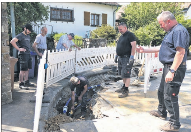
Wassermeister Harald Mager und Polier Lutz Modl (v.re.) nehmen die Notwasserleitung in Betrieb. Foto: bpa
