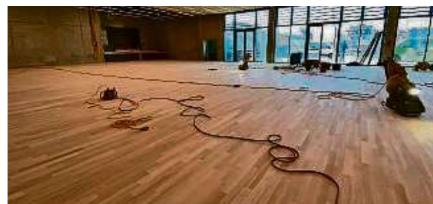
Da ist was schiefgelaufen: Teile des Parketts im Stadthaus werden erneuert.
