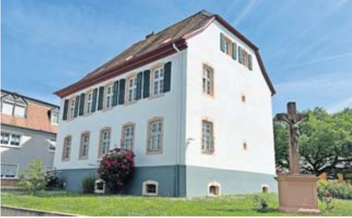
Auch von der Straßenseite aus kann man die mühevoll sanierte Fassade bewundern.
