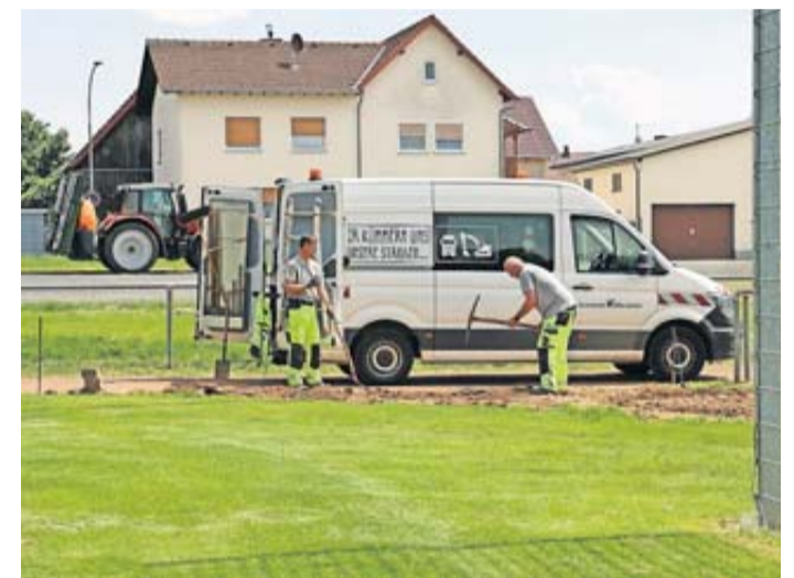
Entstehung der neuen Laufbahn.
