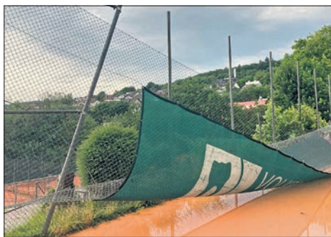
Sturmschäden beim TC Eppstein Foto: privat
