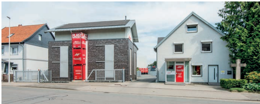
1896 an den Start gegangen, stellt sich die ehemalige Umzugsspedition Heinrich Niemann heute neu auf: Als reines Selfstorage wird mutig in die Zukunft geguckt.
