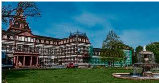
Noch bis Ende des Jahres werden Teile von Schloss Philippsruhe wegen der umfassenden Fassadensanierung von einem Gerüst verdeckt sein.
