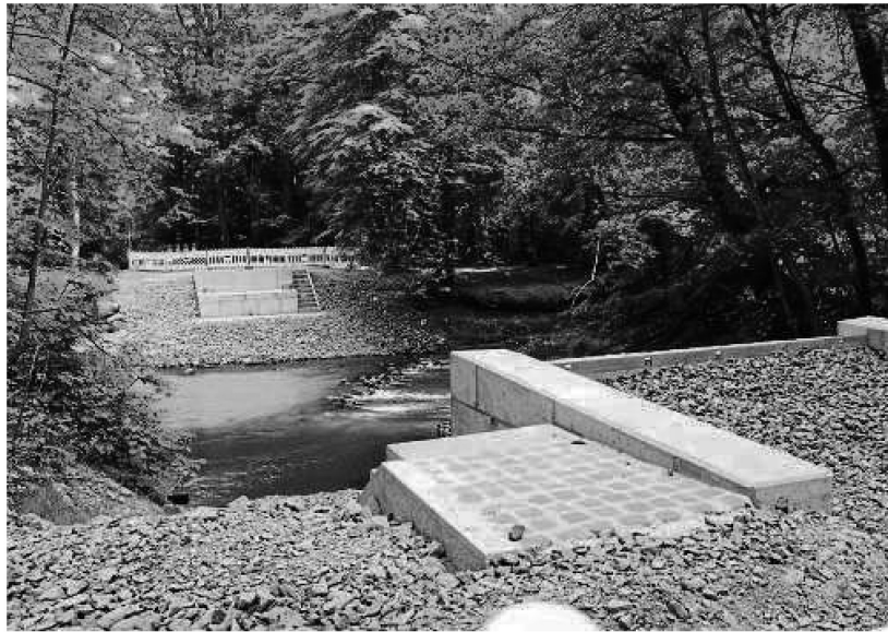
Die Widerlager stehen schon: Voraussichtlich im Juli soll die Brücke dann mithilfe eines Spezialkrans eingehoben werden – sofern bis dahin die Genehmigungen für die erforderlichen Schwertransporte vorliegen.
