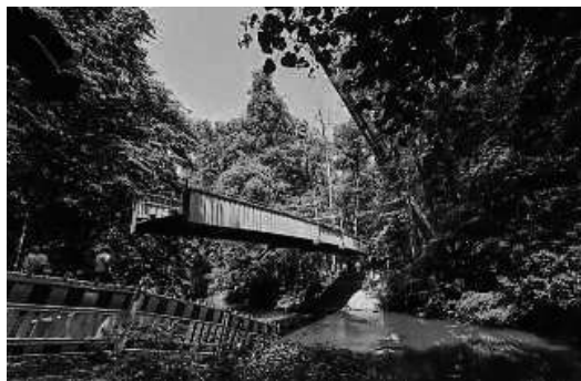
Kommt eine Brücke geflogen: Mit dem Kran wird der Steg über die Kinzig eingehoben.
