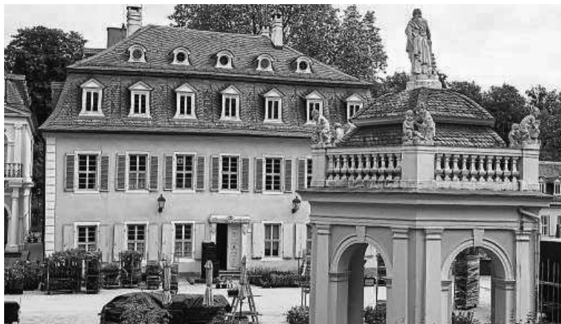
Im ersten Schritt des großen Sanierungsprojekts soll das Badehaus hergerichtet werden.
