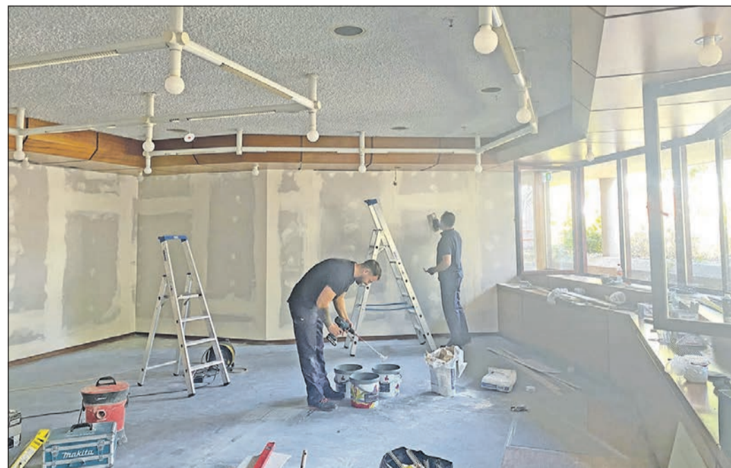
Die Renovierungsarbeiten in den Mehrzweckräumen haben begonnen.
