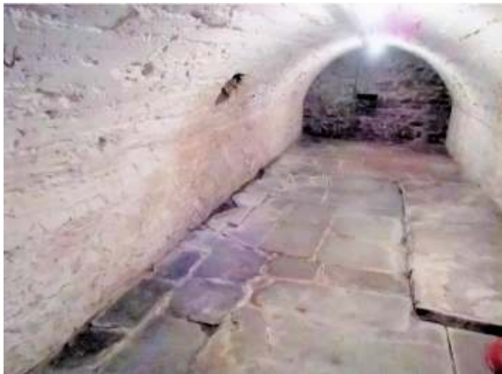
Das Kellergewölbe in der Burgstraße 10.
