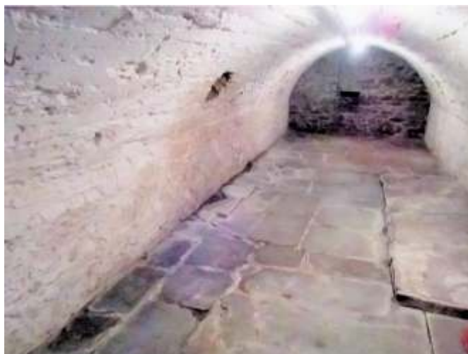
Das Kellergewölbe in der Burgstraße 10.
