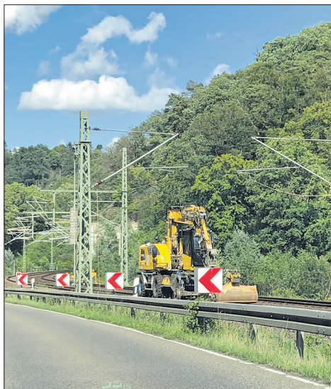
Gleisbauarbeiten dauern noch bis 21. August.
