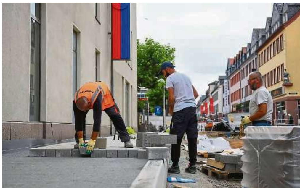
Voraussichtlich Ende August beginnt in der Römerstraße der zweite Bauabschnitt. Dann ist auch die Zufahrt zur Tiefgarage am Marktplatz wieder möglich. FOTO: PM
