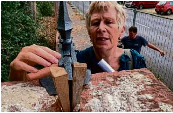
Susanne Sittinger überprüft die Verankerung eines Zaunelements im Pfeilerschaft.
