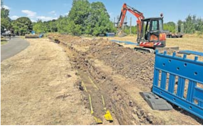
Hier wird Platz für die Leitungen geschaffen.
