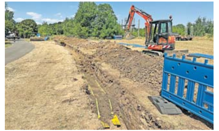
Hier wird Platz für die Leitungen geschaffen.
