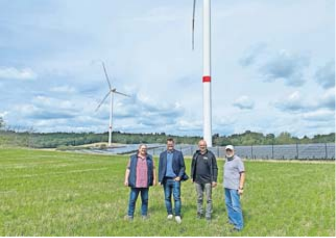
Bürgermeister Ralf Schuster, Bürgermeister Sebastian Wysocki, Erster Beigeordneter Albert Reiß und Dr. Jochen Ohl, Geschäftsführer der 3P Energieplan GmbH, schauen sich die fast fertige Freiflächen-Photovoltaik-Anlage an. (von links)
